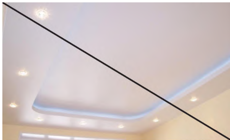
Плохо Многоуровневые гипсокартонные конструкции
